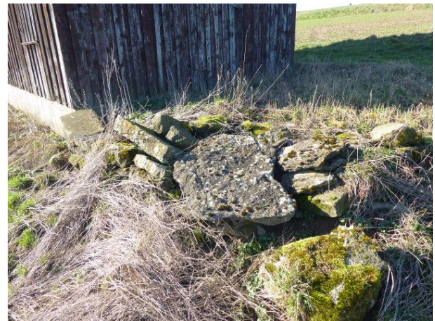
Abb. 12: Steinlager mit Hohlräumen an der Feldscheune von Abb. 9.
